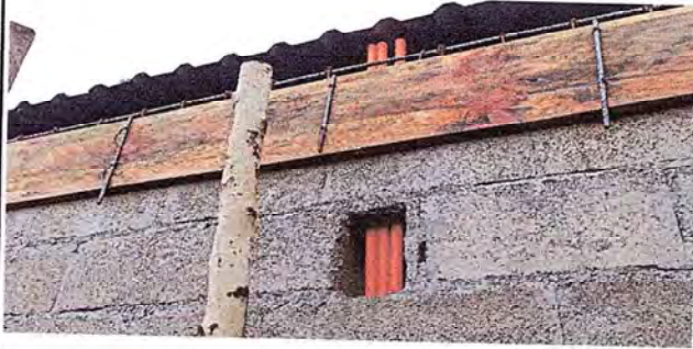
Foto 7: Primeras instalaciones de red de sistema eléctrico en área de servicios sanitarios.
