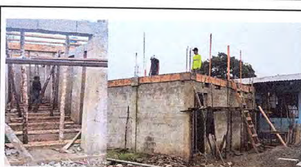
Foto 4: En espera de la fundición de losa para el almacenamiento de 2 cisterna de almacenamiento de agua de 2500 litros cada uno.
