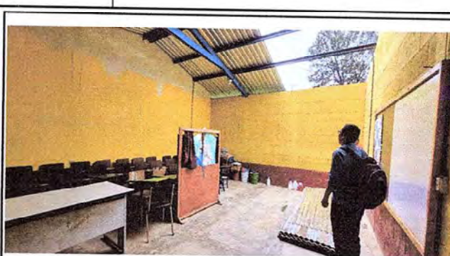
Foto 2: Vista interna del cambio de techo del aula 10.
