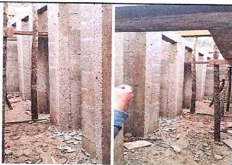
Foto 3: Área para instalar las puertas de los baños aun en proceso por avance de trabajos de mejoramiento y tallado de paredes.
