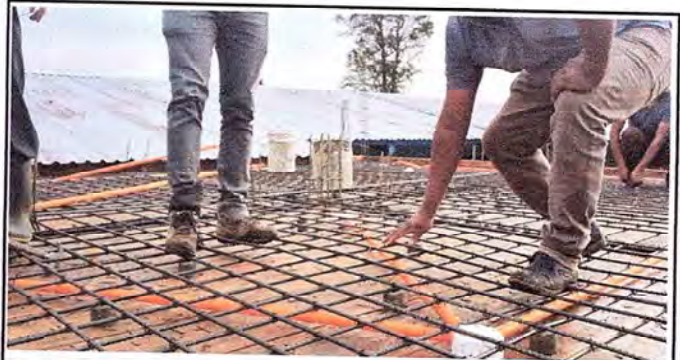
Foto 10: Materiales aún disponibles para completar el mejoramiento de la base del agua potable y cubierta de los nuevos sanitarios.
