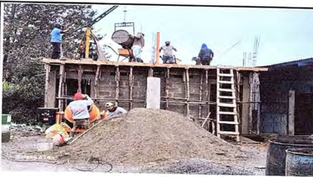
Foto 9: Fundición de losa con función de techo para baños, base para almacenamiento de agua potable
