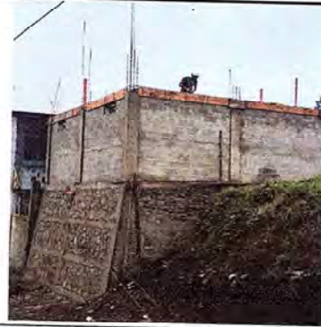
Foto 8: Vista actual del muro de contención y base para tinaco de almacenamiento de agua potable.
