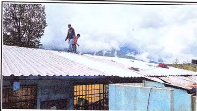
Foto 1: Sustitución de estructura de techo en área del aula 10.
